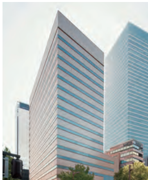
桜通豊田ビル
