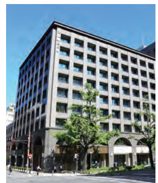
大阪豊田ビル
