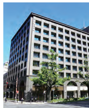
大阪豊田ビル
