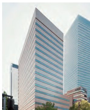
桜通豊田ビル
