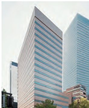
桜通豊田ビル
