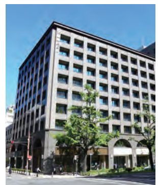
大阪豊田ビル
