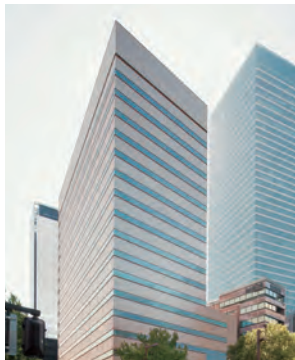
桜通豊田ビル
