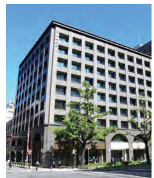
大阪豊田ビル
