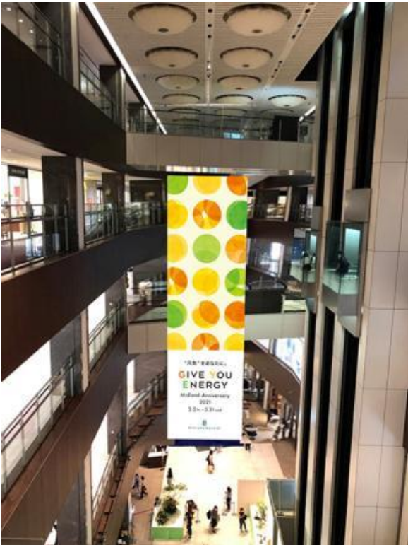
【商業棟】1F吹き抜け天井吊り
