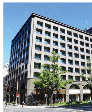
大阪豊田ビル
