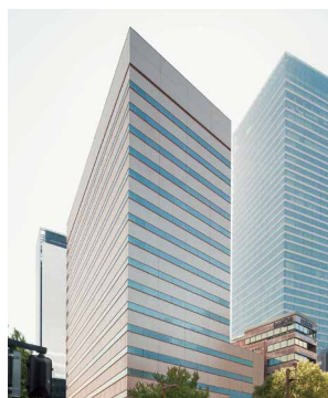
桜通豊田ビル
